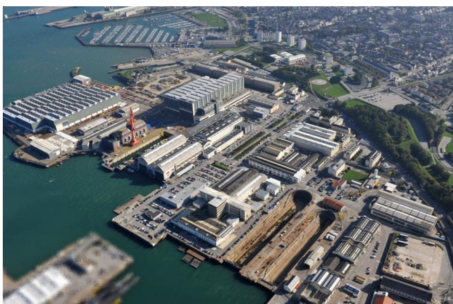
Le chantier de Cherbourg (© NAVAL GROUP)
